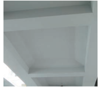
長寿命化対策後
