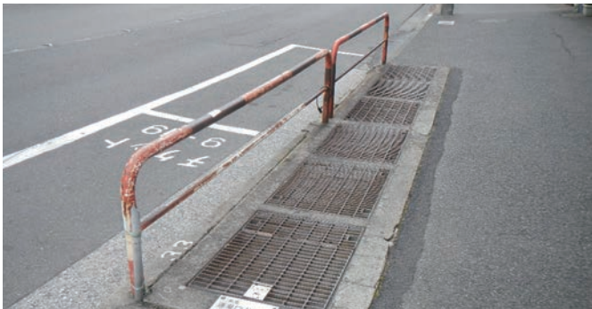
対策前の換気口
