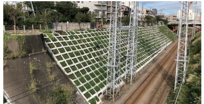
対策後の斜面（同区間）
