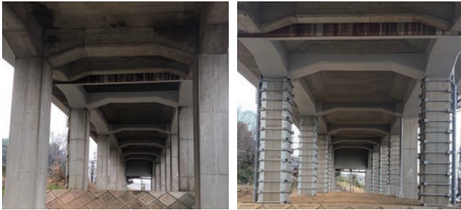
長津田第一高架橋耐震工事前
