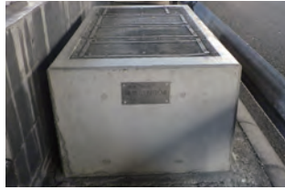
対策後の換気口
