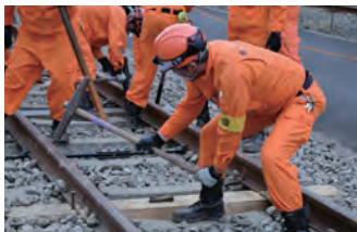
工務部による線路復旧作業
