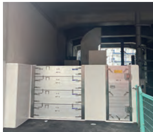
止水板設置後
