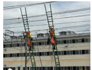
電気部門での技能競技会：電車線の張り替え作業
