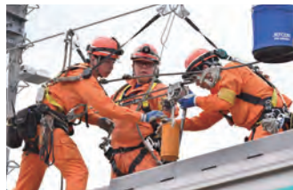
電気部による架線復旧対応
