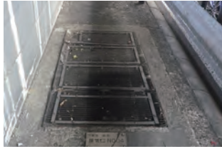
対策前の換気口
