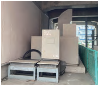
止水板設置前
