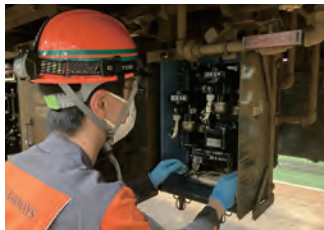
車両床下の点検
