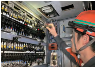
車両を制御する運転台点検
