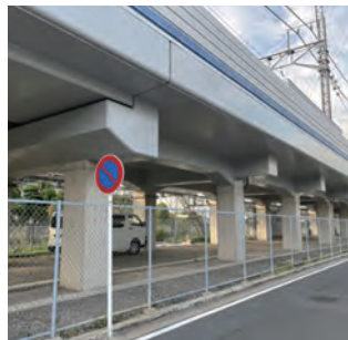
長寿命化対策後
