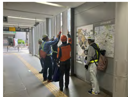
構造物の検査
