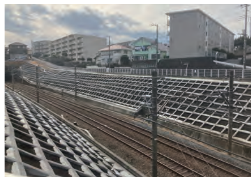
対策後の斜面（同区間）
