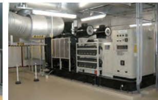
停電時に稼働する駅の非常用発電機
