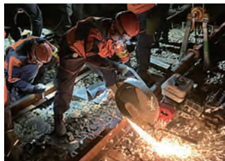
レール切断作業
