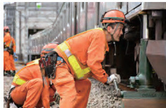
事故車両の脱線復旧作業
