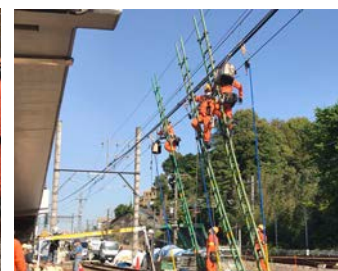
電気部門での技能競技会：電車線の張り替え作業の様子
