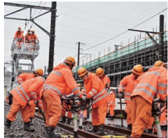
保線係員が線路の歪みを直している様子
