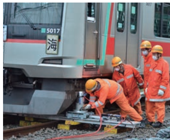
車両係員が脱線した車両を復旧させている様子
