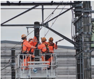
電気係員が電車線を張り替えている様子
