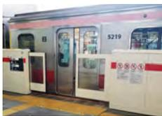
お客さまがホームから転落したり、列車と接触したりする事故を防止するため、東横線・目黒線・東急新横浜線・田園都市線・大井町線の全駅にホームドアを設置しています。また、池上線・東急多摩川線の全駅には、センサー付固定式ホーム柵を設置しています。ホームドアにはセンサーが設置されており、閉まりかけた際に人や荷物を感知するとホームドアが開きます。また、ホームドアが正常に閉まったことを確認できないと列車が発車できない仕組みとなっています。
