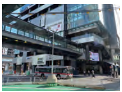
渋谷フクラスへ接続する 歩行者デッキ
