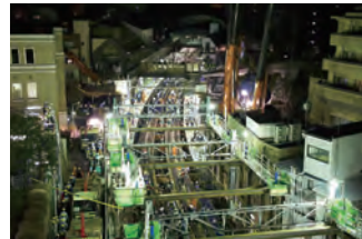
代官山駅地下化切替工事（2013年）
