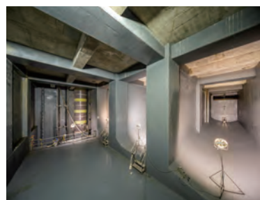
渋谷駅東口雨水貯留施設
