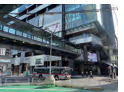
渋谷フクラスへ接続する 歩行者デッキ
