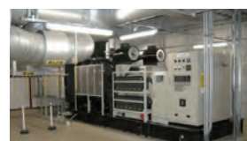
停電時に稼働する駅の非常用発電機
