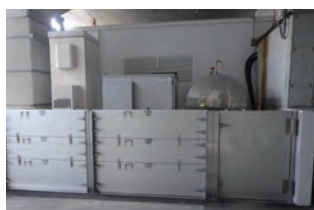
止水板設置後
