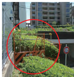
速やかに設置した仮の柵
