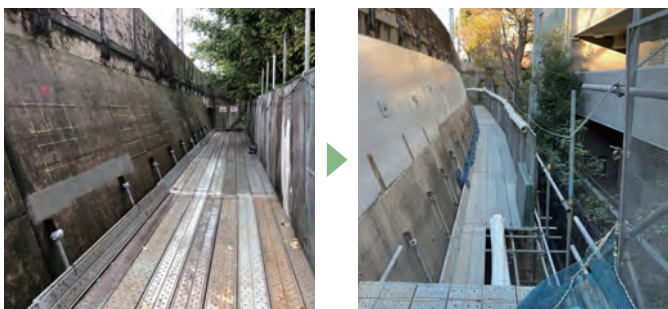
擁壁補強：田園都市線用賀駅～二子玉川駅間 擁壁補強工事前と工事後
