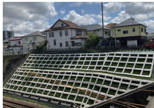
対策後の斜面（同区間）
