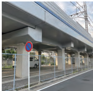
長寿命化対策後
