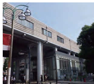
都立大学駅高所外壁 改修工事前と工事後
