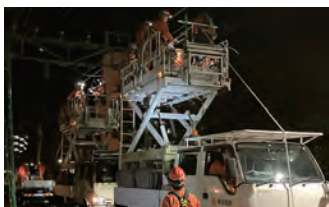
軌陸車を使用した架線設備点検
