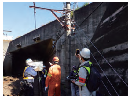
構造物の検査
