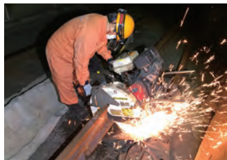
レール切断作業
