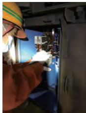
車両床下の点検
