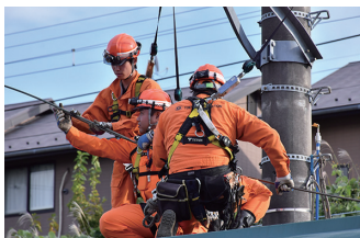
電気部による架線復旧対応
