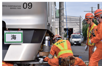
事故車両の脱線復旧作業
