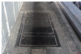
対策前の換気口
