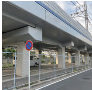
長寿命化対策後
