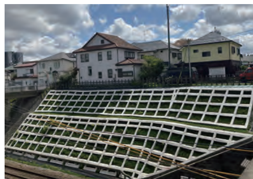
対策後の斜面（同区間）
