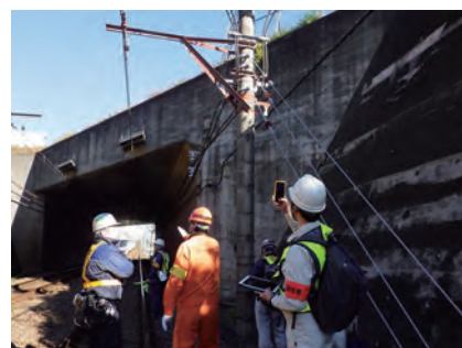
構造物の検査
