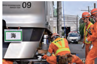
事故車両の脱線復旧作業
