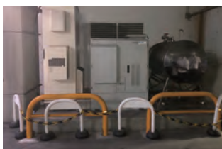
止水板設置前
