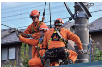
電気部による架線復旧対応
