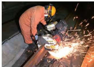
レール切断作業
