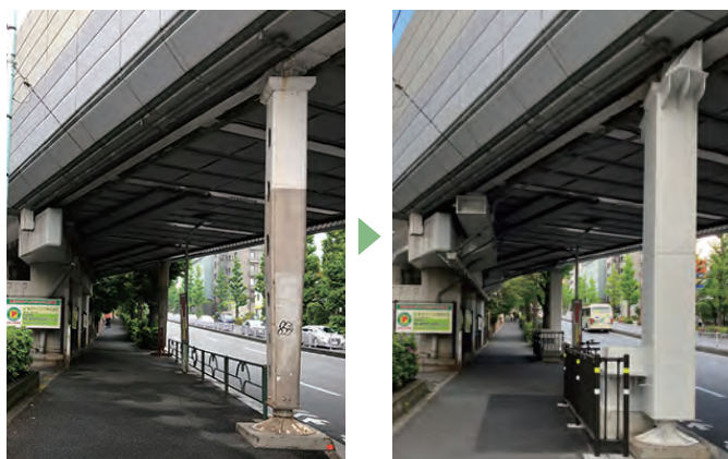
ロッキング橋脚：東横線学芸大学駅～都立大学駅間（放射 3 号架道橋）耐震工事前と工事後
