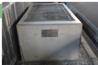
対策後の換気口
