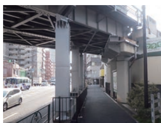
ロッキング橋脚：大井町線旗の台～北千束間（中原架道橋）耐震工事前と工事後
