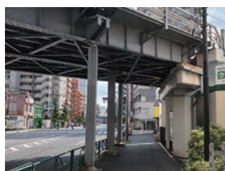
ロッキング橋脚：大井町線旗の台～北千束間（中原架道橋）耐震工事前と工事後
