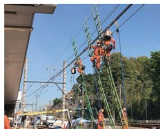
電気部門での技能競技会：電車線の張り替え作業
