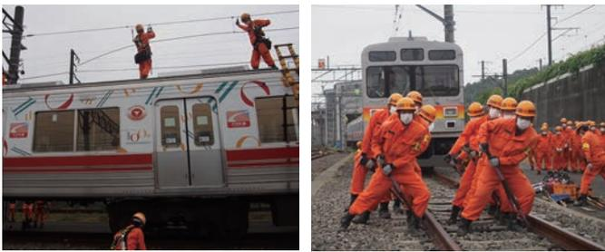
電気係員による電車線張り替え作業
