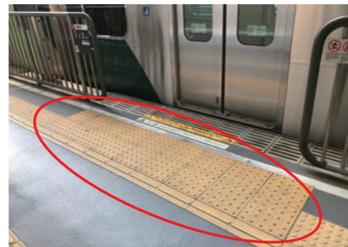
内方線付き 点状ブロック
