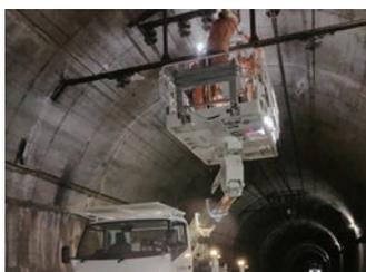
軌陸車を使用した架線設備点検の様子
