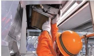
コーティングが完了した空調フィルターへの交換作業の様子
