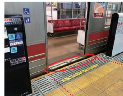
お客さまが足を踏み外して列車とホームとの隙間に転落しないように、ホームの側面に隙間を狭めるための転落防止ゴムの設置を順次進めています。
