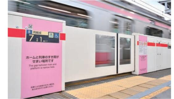
お客さまがホームから転落したり、列車と接触したりする事故を防止するため、東横線・目黒線・田園都市線・大井町線の全駅にホームドアを設置しています。また、池上線・東急多摩川線の全駅には、センサー付固定式ホーム柵を設置しています。
