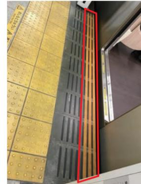
ホームの先端部をオレンジ色に塗装し、線路転落や、列車とホームとの隙間への転落を防ぐため、お客さまへの注意喚起を行っています。ホームにも足元注意ステッカーの表示を行っています。
