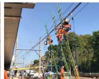
電気部門での技能競技会：電車線の張り替え作業の様子
