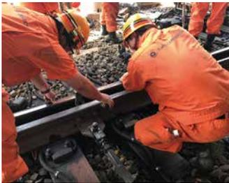
分岐器レール交換作業の様子
