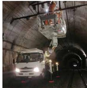
軌陸車を使用して架線設備を点検して
