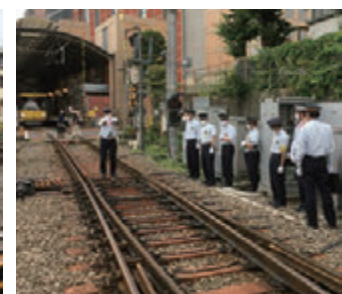
転てつ器が正常な状態か確認している様子
