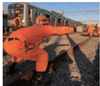
保線係員が線路の歪みを直している様子
