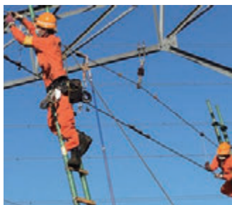
電気係員が電車線をはり替えている様子
