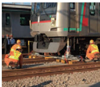
車両係員が脱線した車両を復旧させている様子
