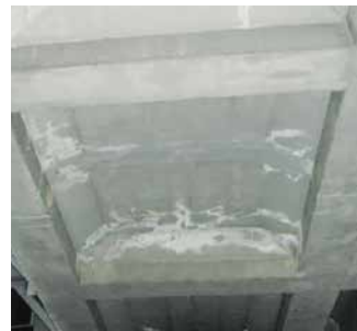
高架橋長寿命化対策前
