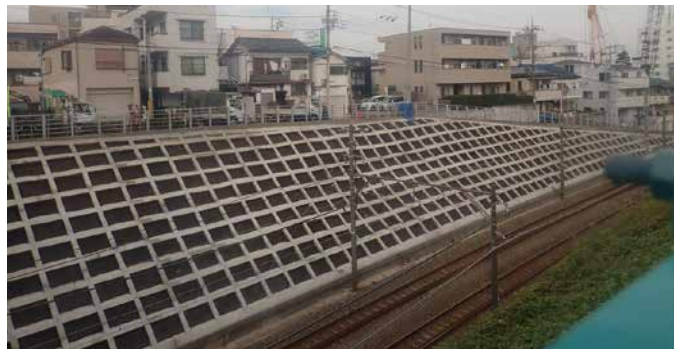
対策後の斜面 (同区間)
