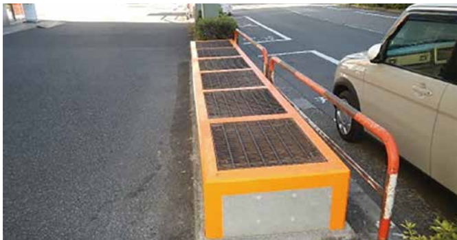
対策後の換気口
