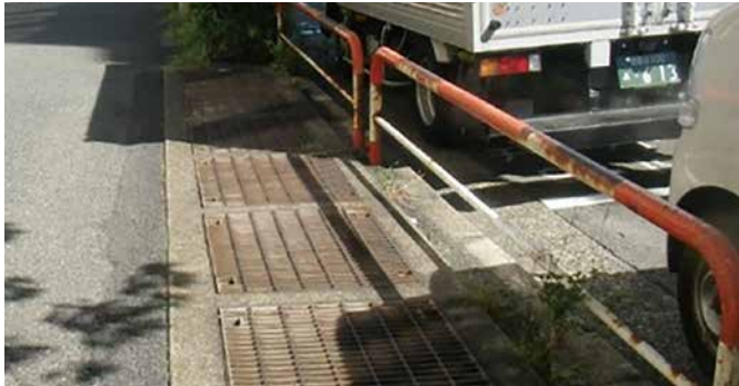
対策前の換気口
