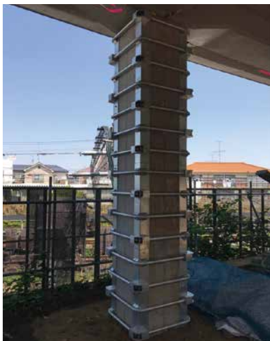
耐震補強工事実施中の長津田第一高架橋
