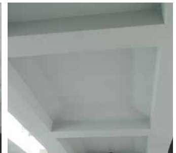
高架橋長寿命化対策後
