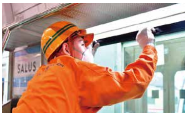
車両窓開け作業の様子
