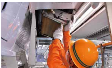
車両の空調フィルターを抗菌スプレーが塗布されたものに交換している様子
