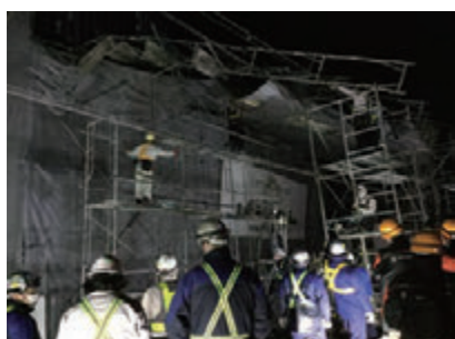
作業員による撤去作業の様子
