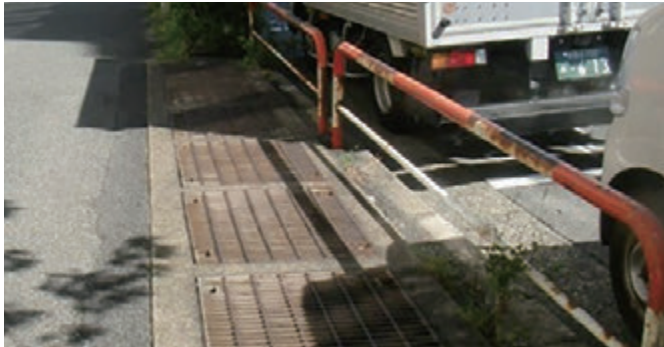
対策前の換気口
