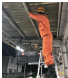
ホーム屋根の点検の様子
