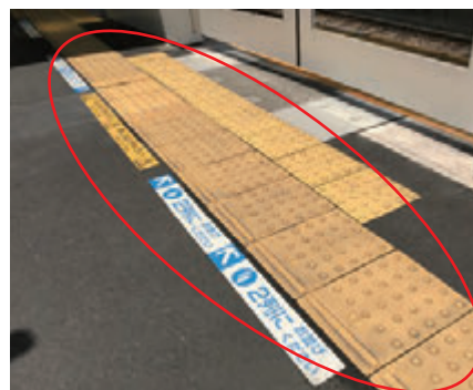
内方線付き 点状ブロック
