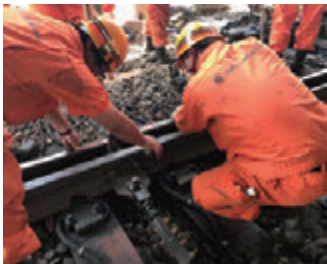
分岐器レール交換作業の様子
