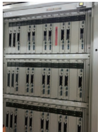
信号制御を行う連動装置
