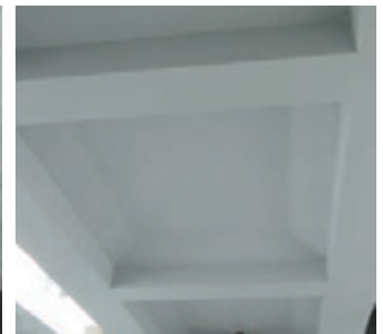
高架橋長寿命化対策後
