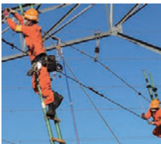
電気係員が電車線をはり替えている様子
