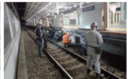
ホームスラブの点検の様子
