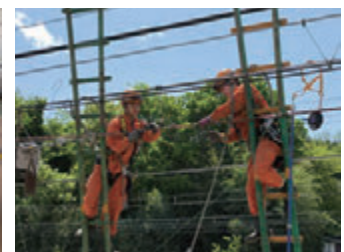
電気部門での技術競技会：電車線のはり替え作業の様子
