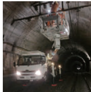
軌陸車を使用して架線設備を点検している様子
