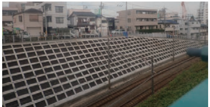
対策後の斜面（同区間）
