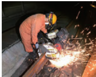
レール切断作業の様子
