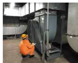
換気設備動作・異常音確認
