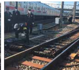
転てつ器（ポイント）を手動で転換している様子
