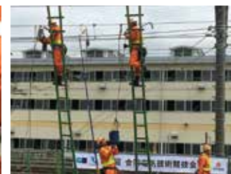
電気部門での技術競技会：架線が切れたことを想定した復旧作業の様子
