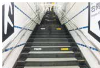
階段蹴込み部分の通行区分表示
