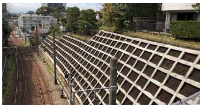
対策後の斜面（同区間）
