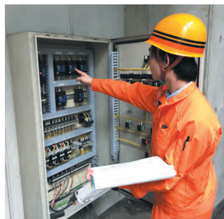
雨水ポンプ盤確認
