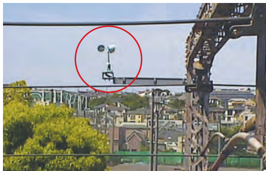
東急線沿線に設置した風速計
