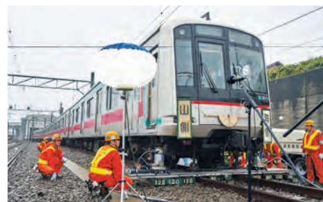
脱線した車両は油圧ジャッキを使用して線路上に復旧させます
