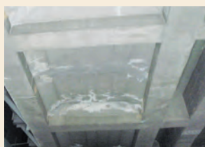
高架橋長寿命化対策前
