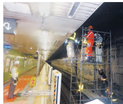
夜間作業による天井材検査
