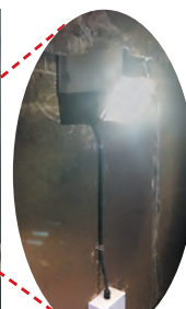
駅間補助照明
