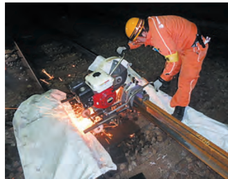
レール交換 (レール切断)
