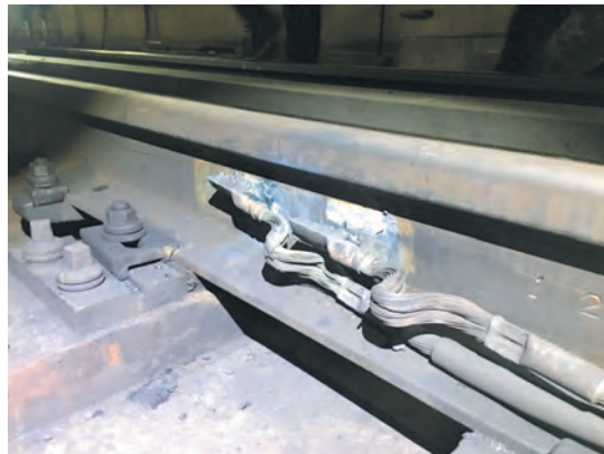
信号用電線が外れた様子
