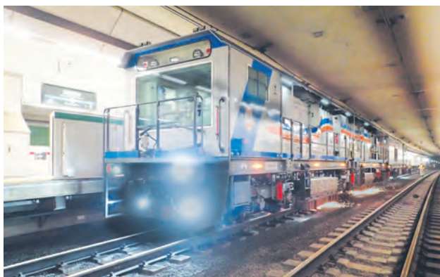
レール削正車による、レール削正
