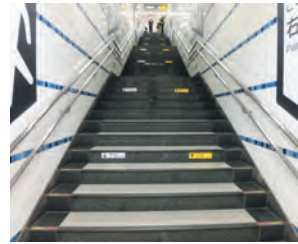
階段蹴込み部分の通行区分表示
