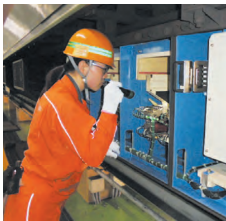
断流器の点検
