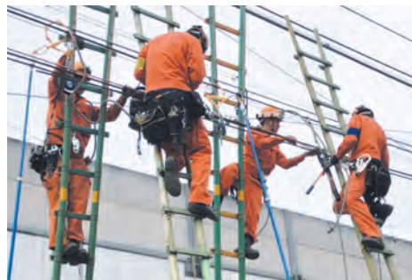
電気部門での技術競技会の一例：架線が切れたことを想定した復旧を行っています。高所作業での復旧はチームワークが必要になります
