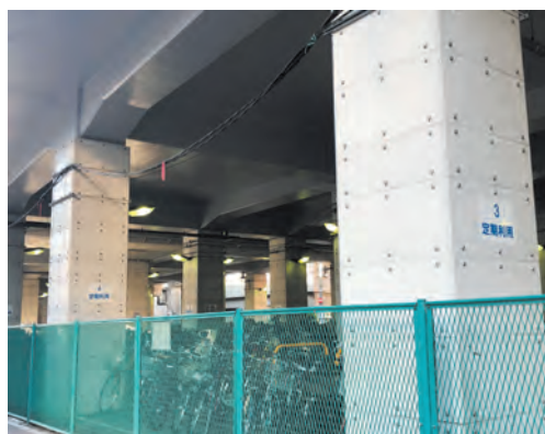
さらなる減災対策を実施した新丸子高架橋
