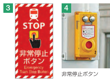
非常停止ボタン案内看板 非常停止ボタン
