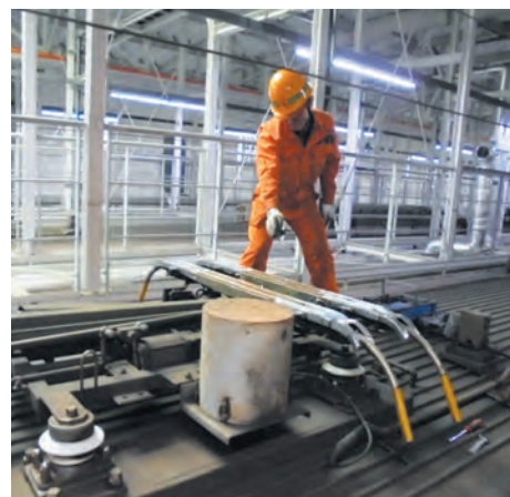
パンタグラフの点検
