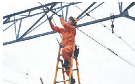
損傷した架線は電気部係員が速やかに復旧します
