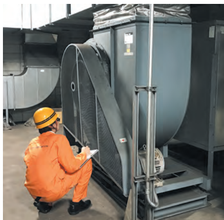
換気設備動作・異常音確認
