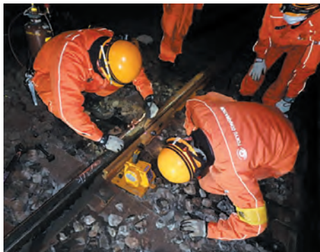
レール交換 (継目板取付)
