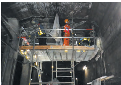
夜間作業によるトンネルスラブ検査
