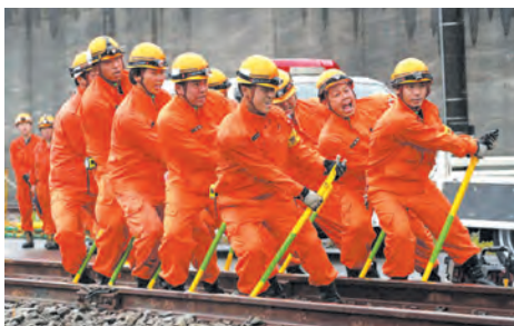
ゆがんだ線路を保線係員が力を合わせて整直します
