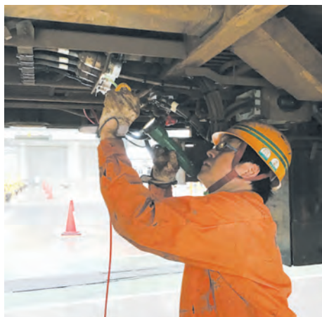
床下配線の点検
