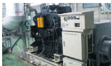
停電時に稼働する、駅の非常用発電機
