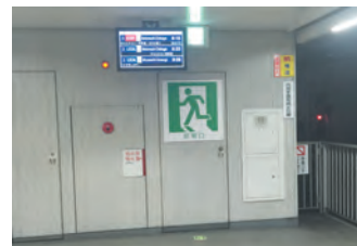
避難通路(非常口のご案内)の表示を大きく分かりやすくしました
