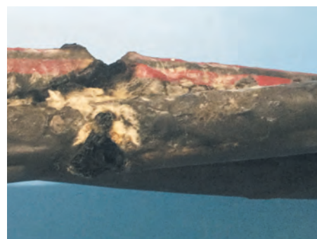
ケーブル損傷箇所拡大
