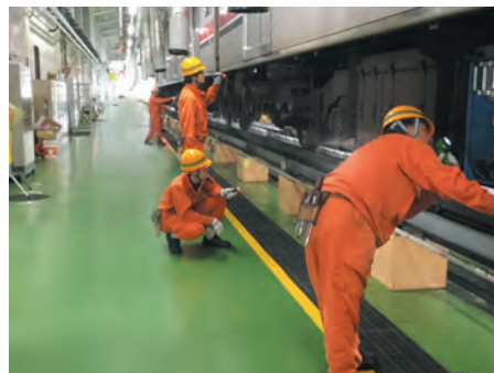
検車区で3か月ごとに実施する床下機器点検
