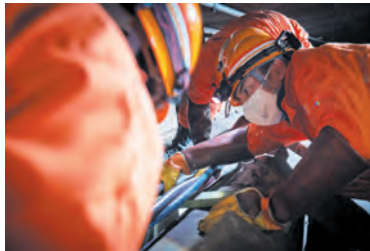
ホーム下(トラフ細部)
