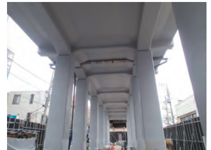
耐震補強工事完了後の高架橋
