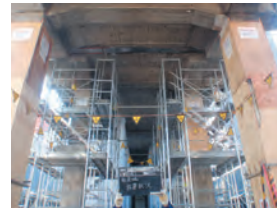
耐震補強工事中の高架橋
