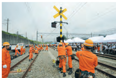
倒壊した踏切警報機を電気係員が速やかに復旧します
