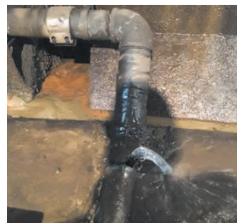
駒沢大学駅～桜新町駅間新玉川線隧道連結送水管不具合による軌道内出水
