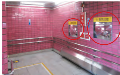
桜新町駅の階段踊り場付近
