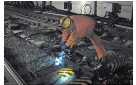
信号設備検査
