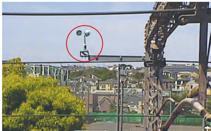
東急線沿線に設置した風速計
