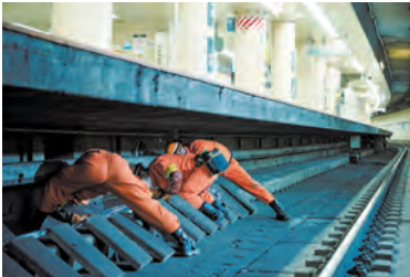
ホーム下(トラフ全体)
