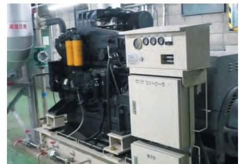
停電時に稼働する、駅の非常用発電機
