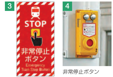
非常停止ボタン案内看板
