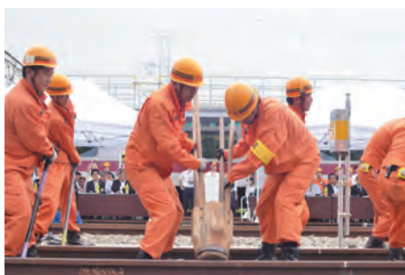
歪んだ線路(軌道)を複数の保線係員が力を合わせて整直します
