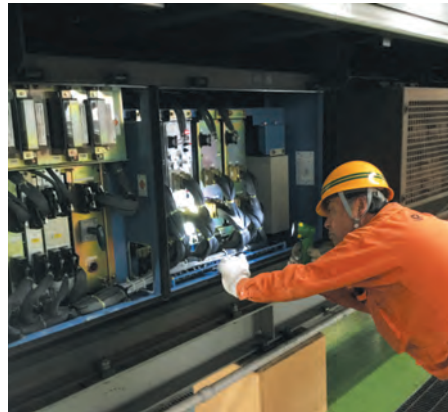
制御装置の点検
