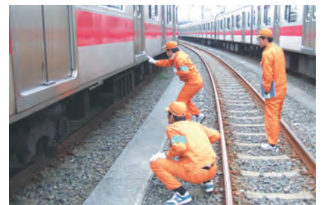
技能講習における車両点検
