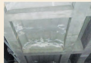
高架橋長寿命化対策前
