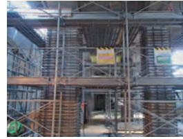
耐震補強工事中の高架橋
