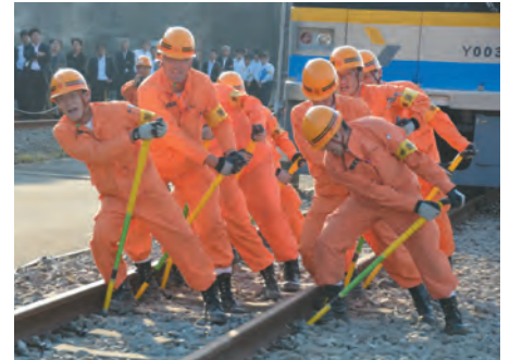
線路(軌道)の幅を直す軌道整正。複数の保線技術員が力を合わせて整正します。
