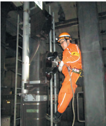
安全帯を用いた信号設備の確認
