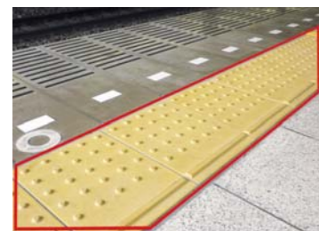
内方線付き点状ブロック
