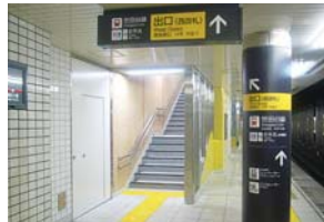
通路を増やして避難経路を確保した三軒茶屋駅
