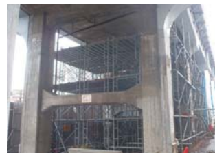
耐震補強工事中の高架橋
