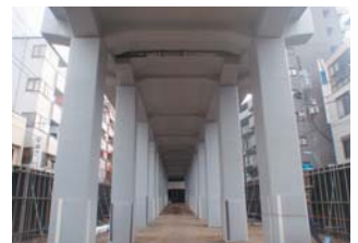
耐震補強工事済の高架橋
