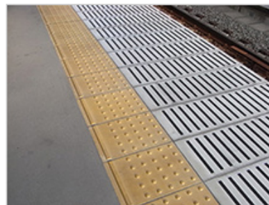
内方線の付いた点状ブロック
