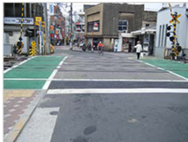
歩道を拡幅した踏切
