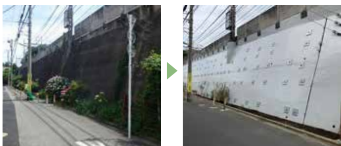
田園都市線用賀駅～二子玉川駅間 擁壁補強工事前と工事後
