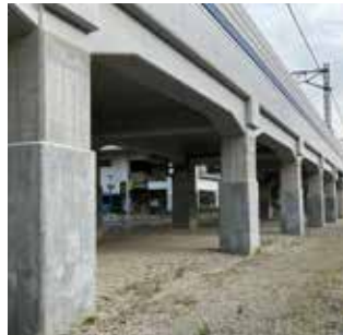
長寿命化対策後
