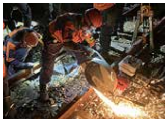
レール切断作業
