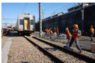
事故車両の脱線復旧作業
