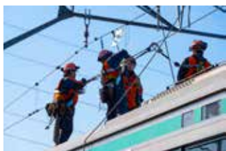
電気部による架線復旧対応
