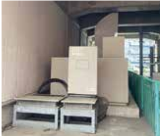
止水板設置前
