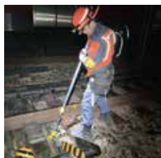
ポイント(転つ機)の検査
