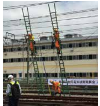
電気部門での技能競技会：電車線の張り替え作業
