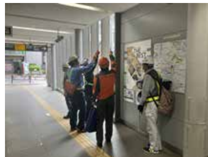
構造物の検査
