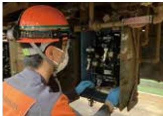
車両床下の点検
