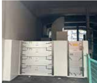
止水板設置後
