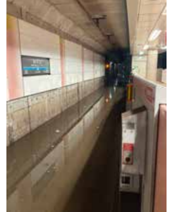
目黒線西小山駅 線路冠水
