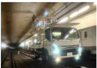
軌陸車を使用した架線設備点検
