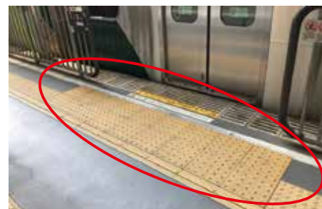
内方線付き点状ブロック
