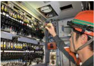
車両を制御する運転台点検
