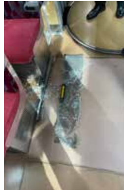
落下した窓ガラス
