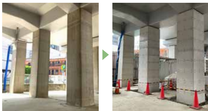
東横線・目黒線多摩川駅～新丸子駅間 高架橋補強工事前と工事後
