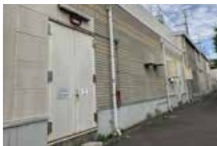
防水扉改修前
