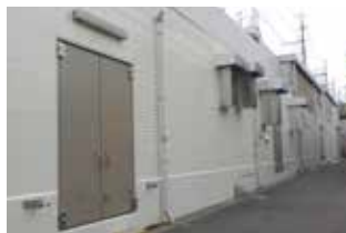
防水扉改修後
