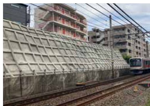
対策後の法面（同区間）
