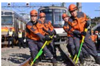
工務部による線路復旧作業
