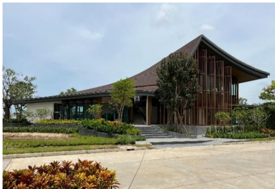
▲共用棟(クラブハウス)
