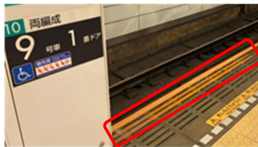
▲くし型状ゴム設置による隙間の縮小
