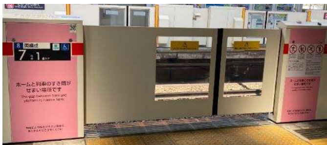
▲段差・隙間の目安値を満たす箇所の表示
