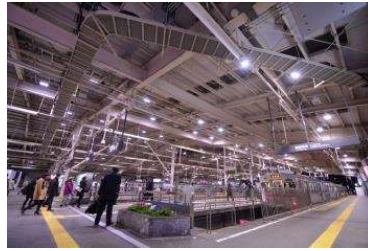
▲LED化した蒲田駅ホーム照明
