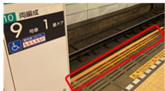
▲くし型状ゴム設置による隙間の縮小
