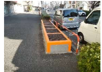
換気口かさ上げ
