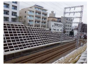
対策後の法面(池上線洗足池～石川台駅)
