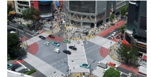
路面の温度上昇を抑制する舗装
