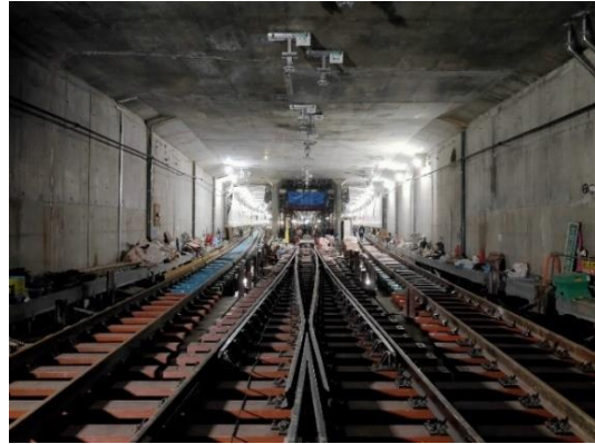
▲羽沢トンネル
