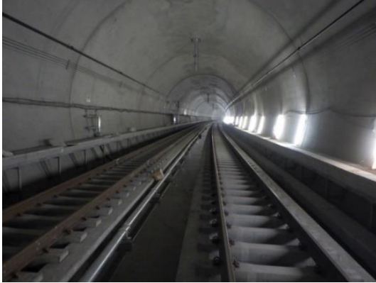
▲羽沢トンネル
