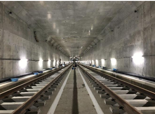
▲綱島トンネル
