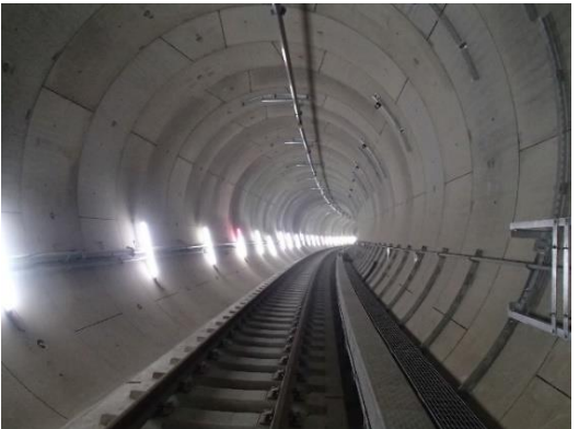
▲綱島トンネル
