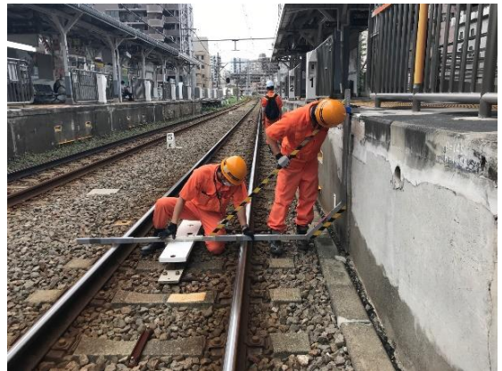
▲建築限界検査状況
