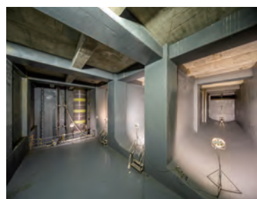
渋谷駅東口雨水貯留施設
