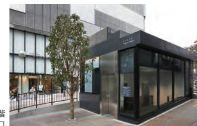
渋谷フクラス地下2階 地域荷捌き駐車場地上出入口
