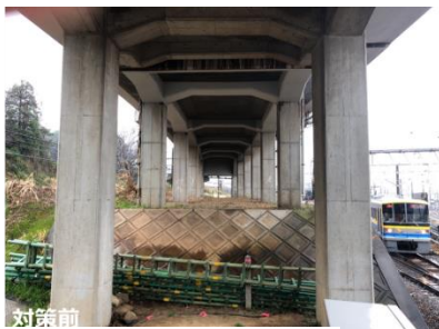
▲耐震補強工事
