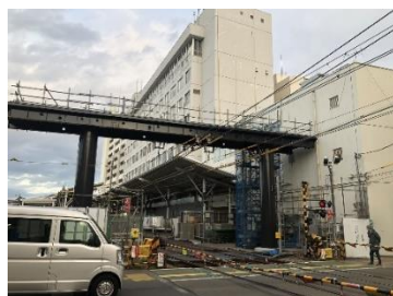
▲工事中の奥沢駅
