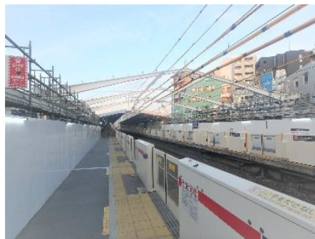
▲都立大学駅 工事の状況
