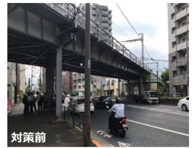
▲ロッキング橋脚を有する橋りょう
