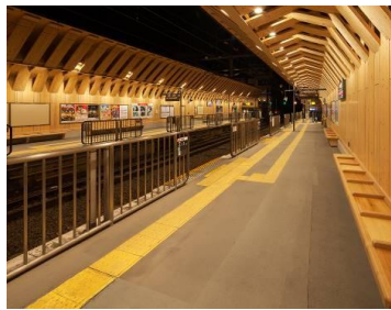
(センサー付固定式ホーム柵)
