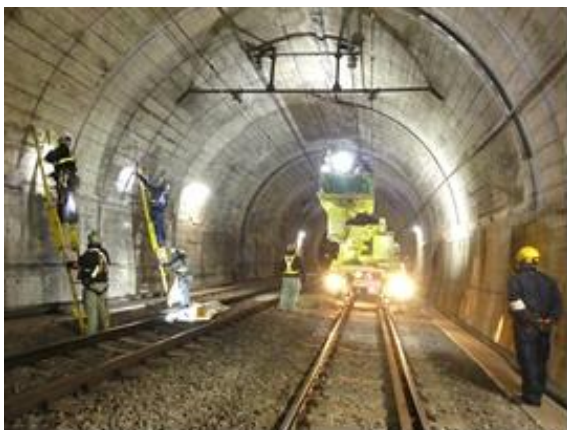
(トンネル打音検査)
