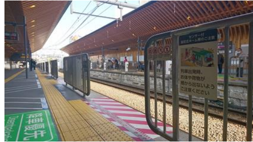
▲池上線市旗の台駅のセンサー付固定式ホーム柵
