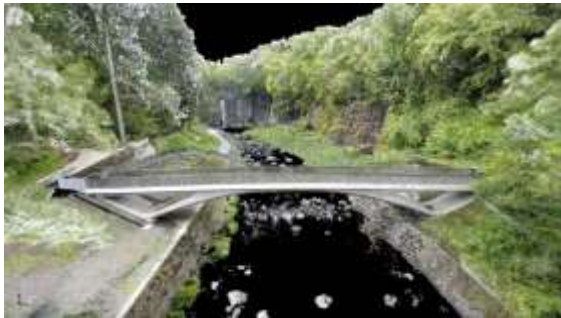
橋梁工事で静岡県が取得した3次元点群データ例
