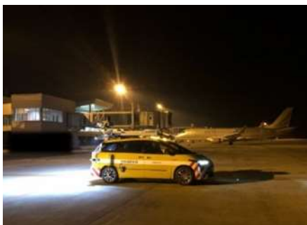
3次元点群データ計測状況(富士山静岡空港)
