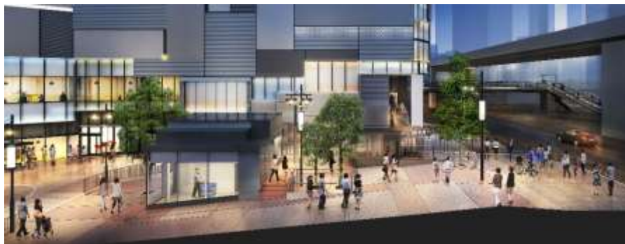
西側周辺街路及び地域荷捌き施設用エレベーター上屋
