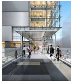
道玄坂連絡デッキ(渋谷駅側から)
