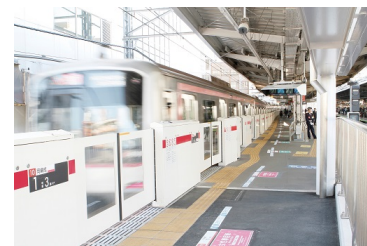
▲ホームドア設置(東急電鉄)
