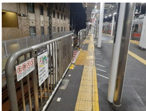
センサー付固定式ホーム柵
