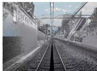
3D点群計測器を用いた施設変状監視 (三次元立体図面の生成)
