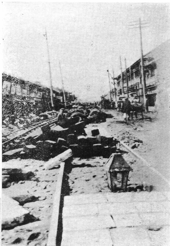
明治四十年頃玉電工事中の道玄坂上
