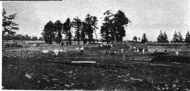
大正十一年整地中の 洗足分譲地
