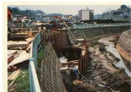
橋梁右岸（地区内側）の橋台工事
