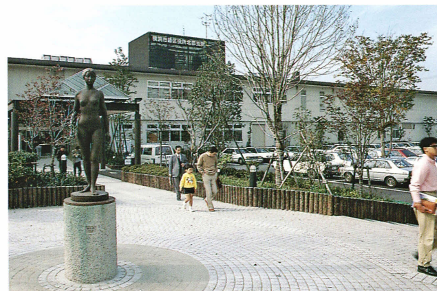
緑区役所北部支所
