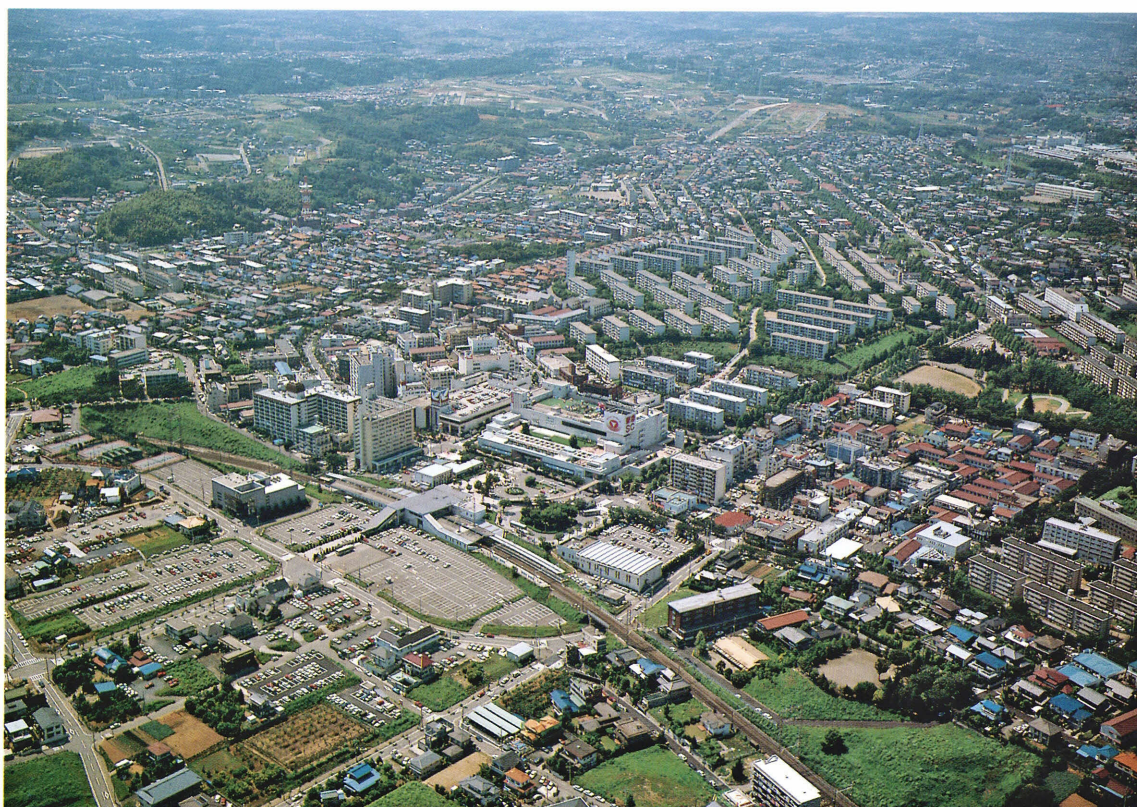
第2ブロック——たまプラーザ駅付近
