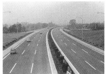
開通した東名高速道路
