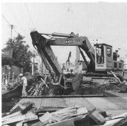
新玉川線の建設工事
