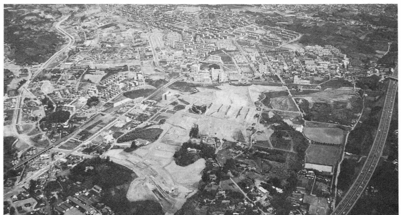
造成工事中の元石川第三地区
