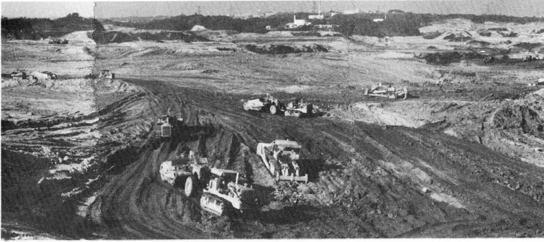
造成工事中の嶮山早野地区
