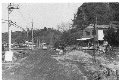
工事中の連絡道路
