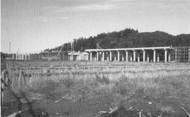
高架橋工事（宮前平駅付近）
