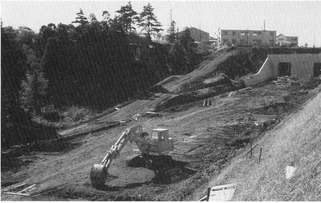
路盤工事（梶が谷駅付近）
