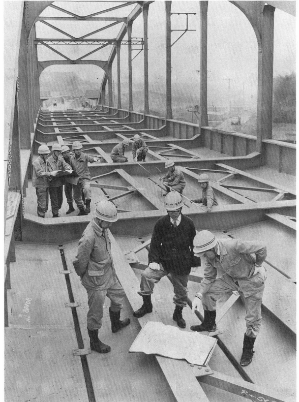
橋梁工事（宮前平駅付近）
