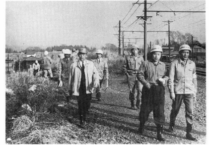
建設ルートを踏査した社長五島昇一行 （長津田駅付近）
