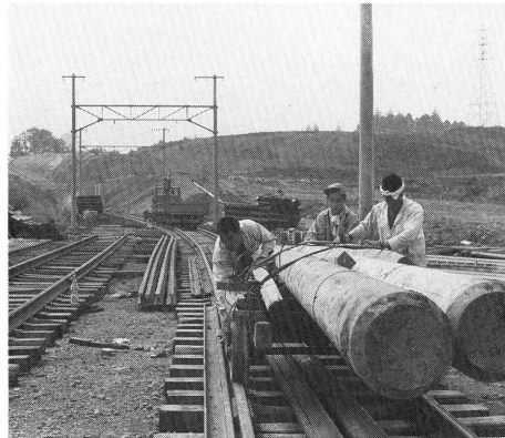
電柱建植工事（たまプラーザ駅付近）
