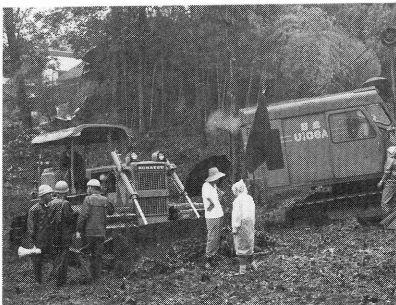
直接施行現場で待機中のブルドーザー
