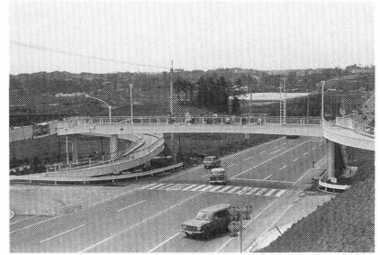
完成した市ヶ尾歩道橋(42年4月)
