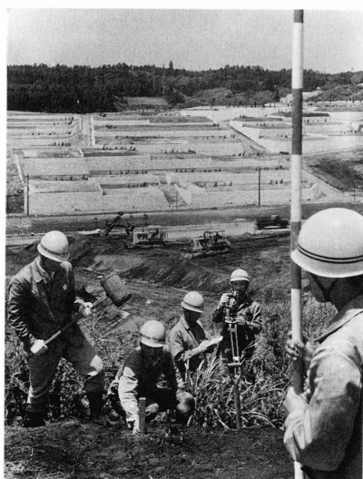
測量中の当社職員(恩田第二地区)
