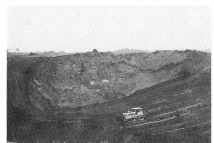
工事中の有馬第一地区
