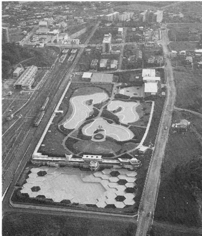
完成した鷺沼プール（プール下が配水池）
