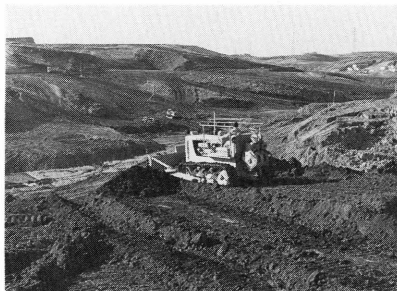
工事中の元石川第一地区
