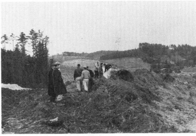
工事中の恩田第三地区
